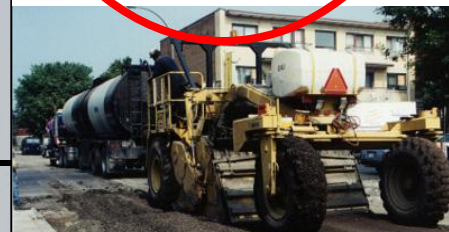
Retraitement en place (type 2)
