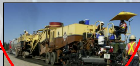
Recyclage à froid des enrobés (type 1)
