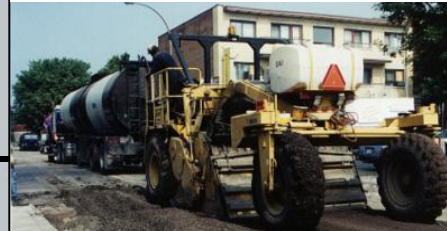
Retraitement en place (type 2)
