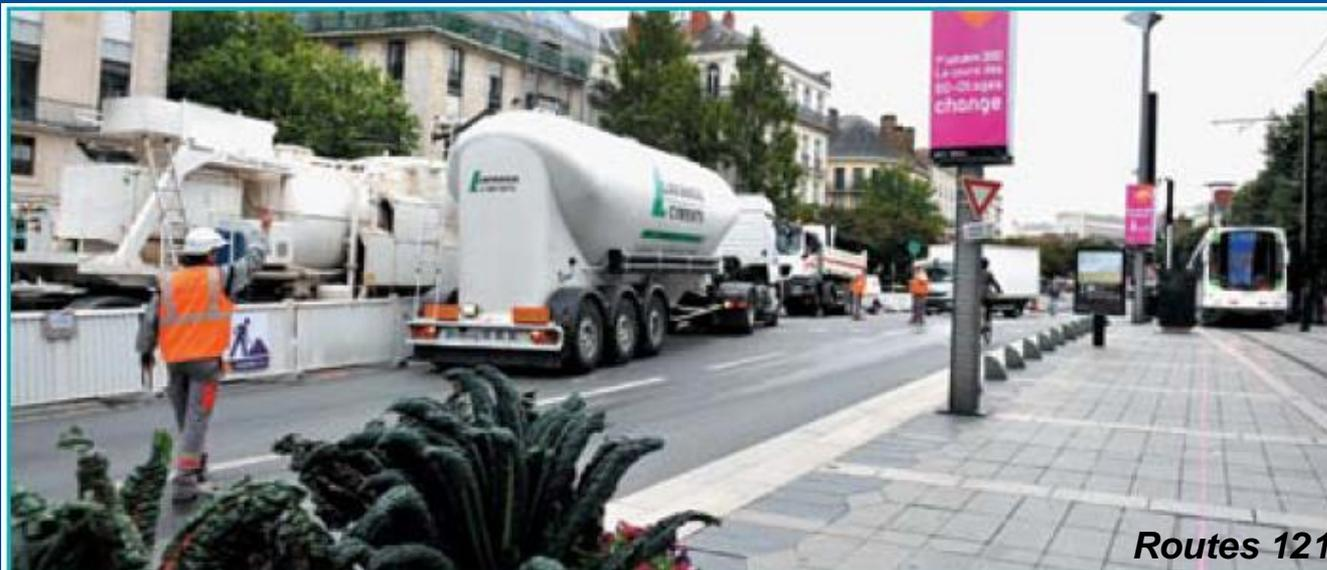
La livraison « juste à temps » du liant hydraulique est faite par gros porteur de 25 tonnes en centre-ville, pour éviter toute rupture d'approvisionnement.
