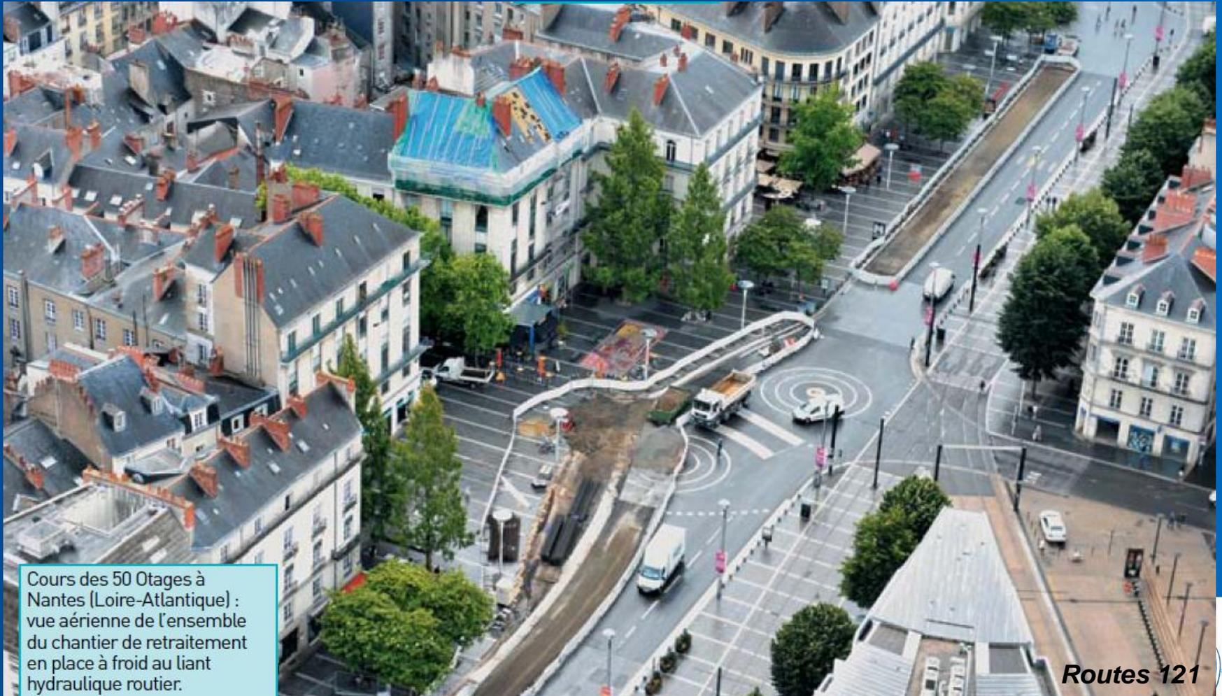
Cours des 50 Otages à Nantes (Loire-Atlantique) : vue aérienne de l'ensemble du chantier de retraitement en place à froid au liant hydraulique routier.
