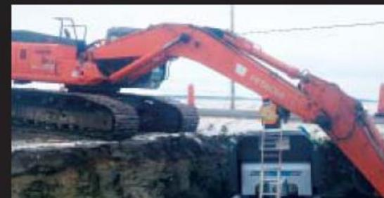
Insertion statique de ponceaux par éclatement ou « static pipebursting ».
