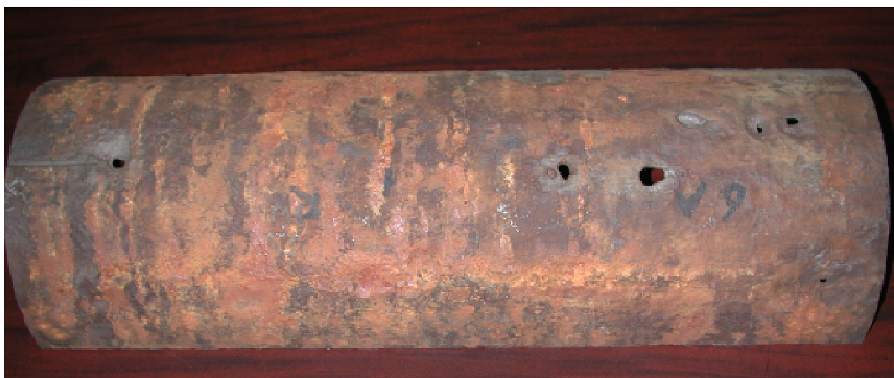
Conduite déterrée dans le site 3
