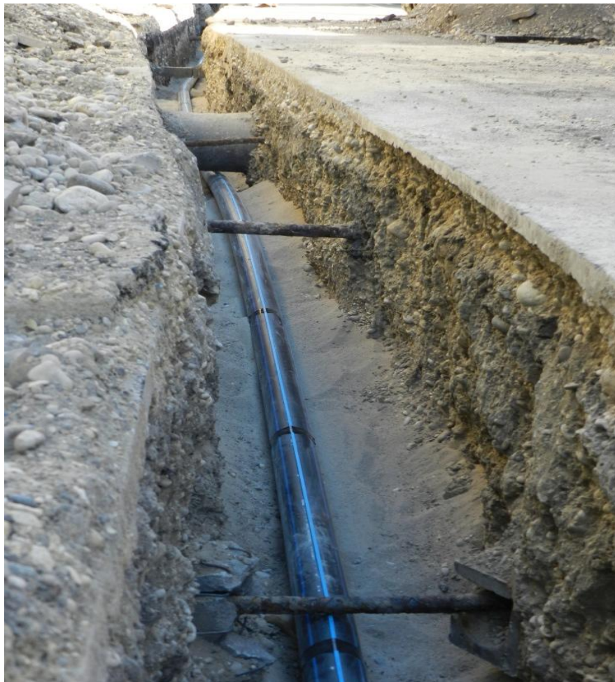
PLYVAL sur réseau EAU en PE
