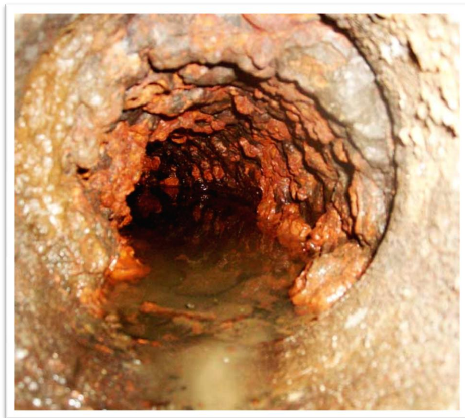
Vue de l'intérieur de la conduite sur la rue Cossette (avant les travaux)
