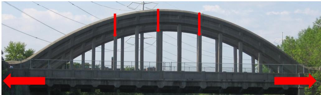
+ Ouverture laissée en place dans les longerons au centre du pont pendant les travaux
