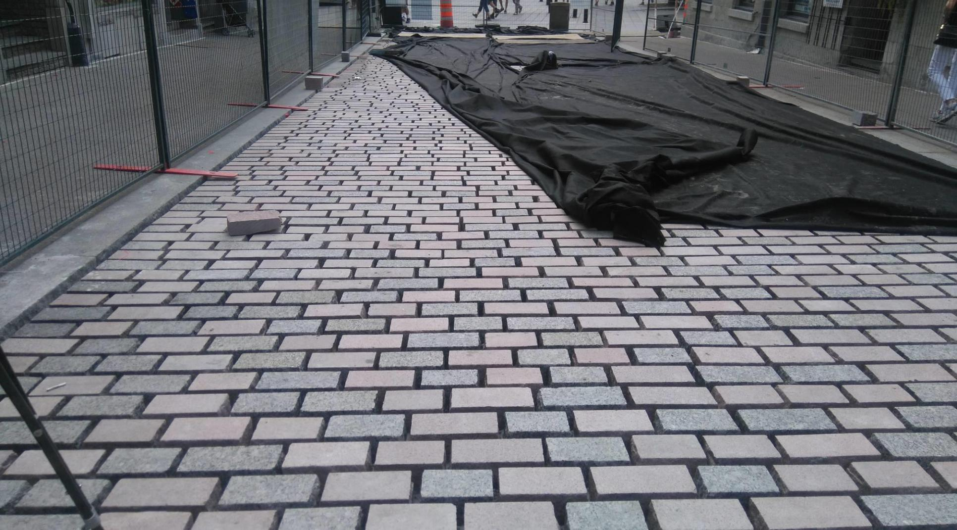
La texture des trois types doit se composer de grain moyen (1-5mm). Chaque type de pavés doit provenir du même site d'extraction (carrière).
