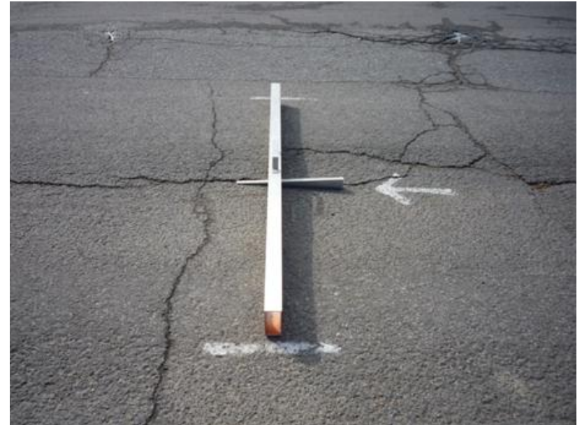
Photo n° 2 : Relevé en condition de chaussée dégelée le 17 mai 2013 (mesure = 19,3 mm)
