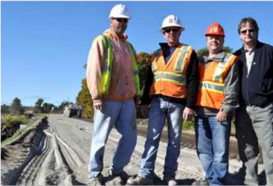
John Curtis, de la compagnie américaine MtCarmel Stabilization, François Robin, de l'entrepreneur en construction L. A. Hébert, Yves Brousseau, de Ciment Québec, et le maire de Saint-Basile, Jean Poirier, sur la route en construction.
