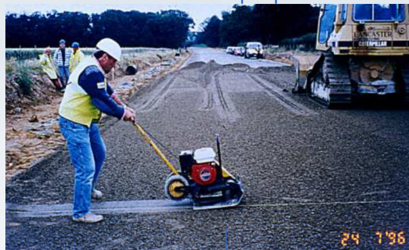
Joint dans la dalle avec plaque vibrante
