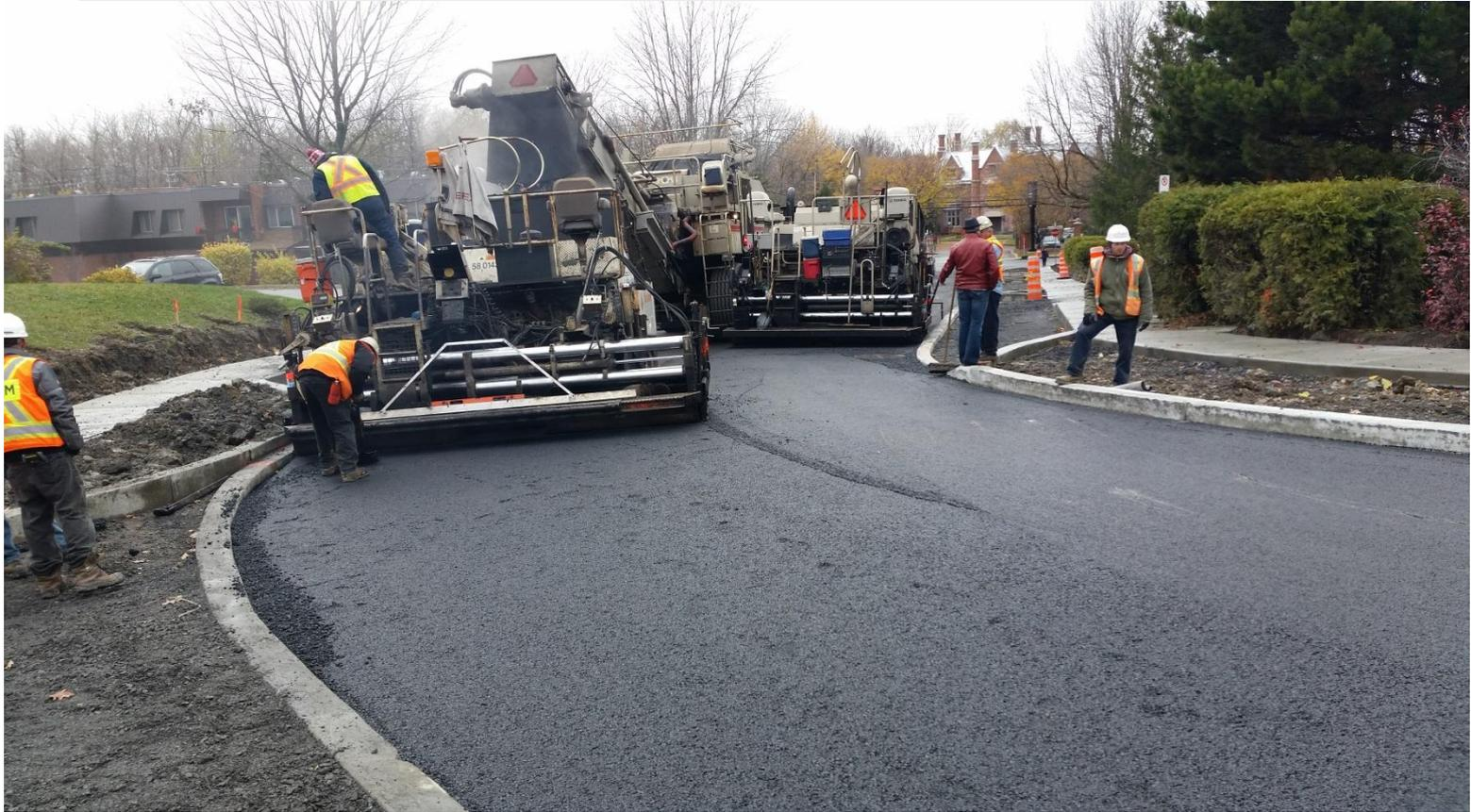
Pas de joint froid – meilleure compaction + étanchéité
