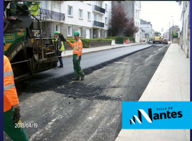
Epaisseur minimale à respecter pour compacter et comportement: reprofilage, composition
