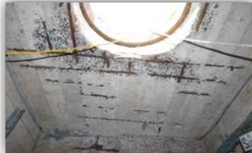
État 5 : corrosion moyenne et délamination
