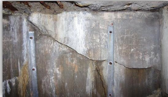
État 6 : fissures avec déplacement délamination et corrosion importante
