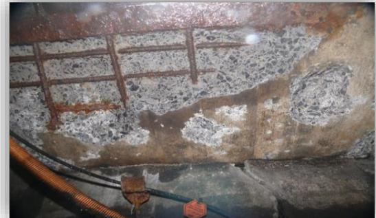
État 7 : délaminage et corrosion généralisés
