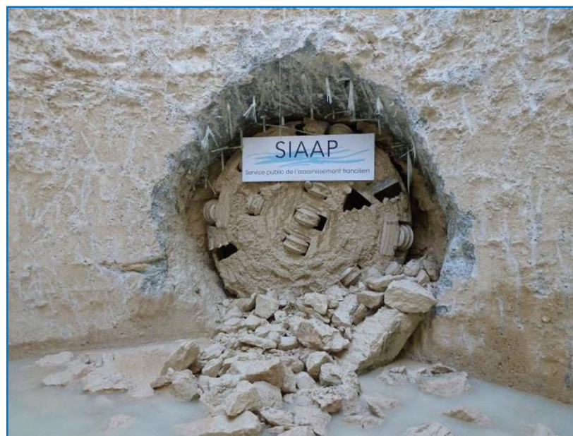
Sortie du micro-tunnelier au puits R1
