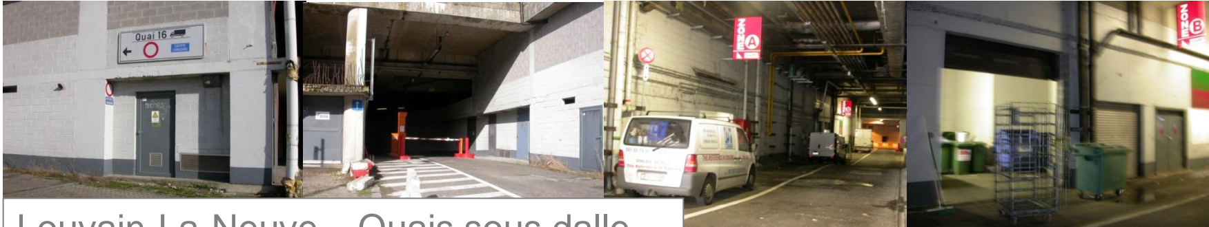
Louvain-La-Neuve – Quais sous dalle
