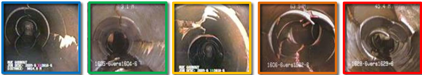
Longueur de conduite en fonction de la dégradation structurale
