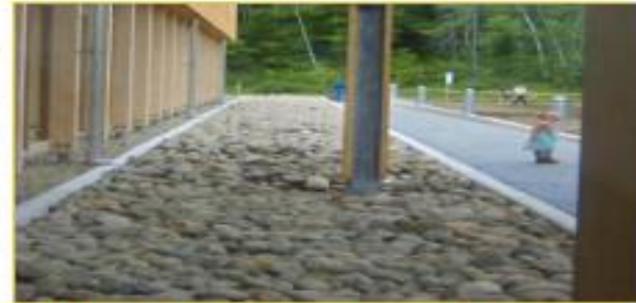
Figure 7.2: Tranchée d'infiltration (Saint-Jean-de-Matha, QC, Canada)
