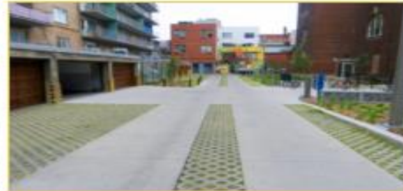
Figure 7.4: Aménagement absorbant (Ville-Marie, QC, Canada)
