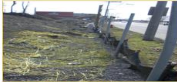
Figure 5.3: Délimitation des zones d'excavation et du terrassement (Écocentre LaSalle, QC, Canada)
