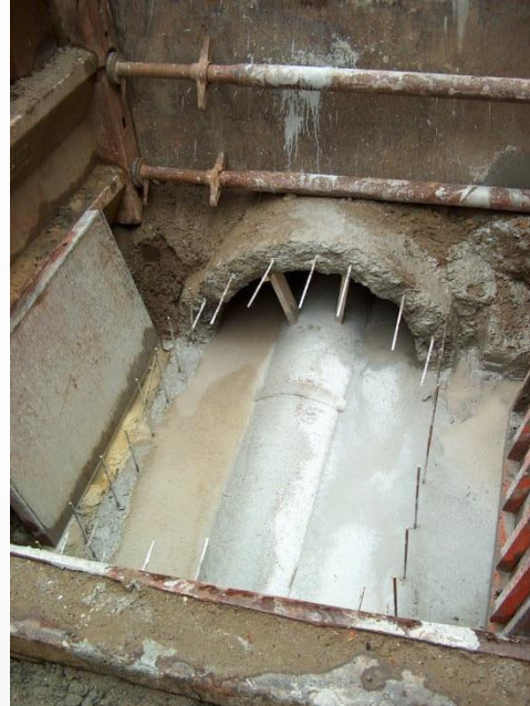
Injection de coulis de ciment
