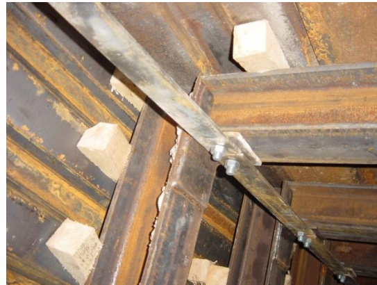
Portiques métalliques, palfeuilles, prédalles et maçonnerie
