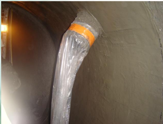
Protection du gunitage avant application de l'époxy
