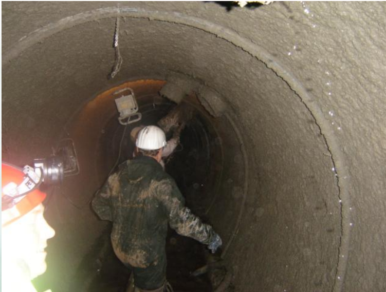
Placement de guides pour lissage à la latte
