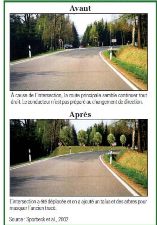
Figure FH-32 Exemple – Bonne transition à l'approche d'une intersection
