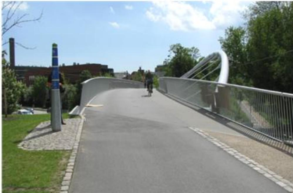
Fig. 20: Déstabilisation par une suspension non orthogonale et asymétrique : l'équilibre est perturbé aux usagers dépendants du champ de vision qui ont tendance à dévier vers la droite (16)
