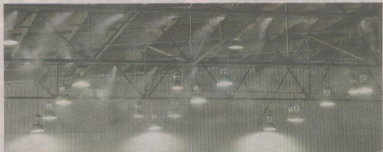
Au site de transbordement de RCI environnement à Longueuil, les vaporisateurs de produit neutralisent l'odeur à l'intérieur du bâtiment. / DOMINIQUE CAMBRON-GOULET/MÉTRO
