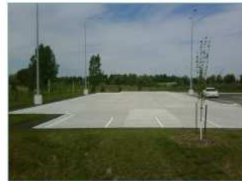
Figure 1. Deuxième essai d'utilisation du béton perméable par le MTO : terrain de stationnement pour usagers de GO Transit aux Parkways à 10 et 11e promenade Williams à Brantford, en Ontario.
