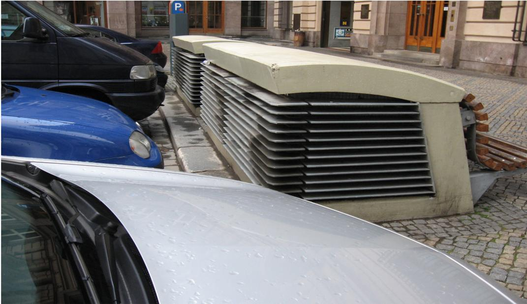
Photo 16 : Prague, bouche d'aération à côté des véhicules
