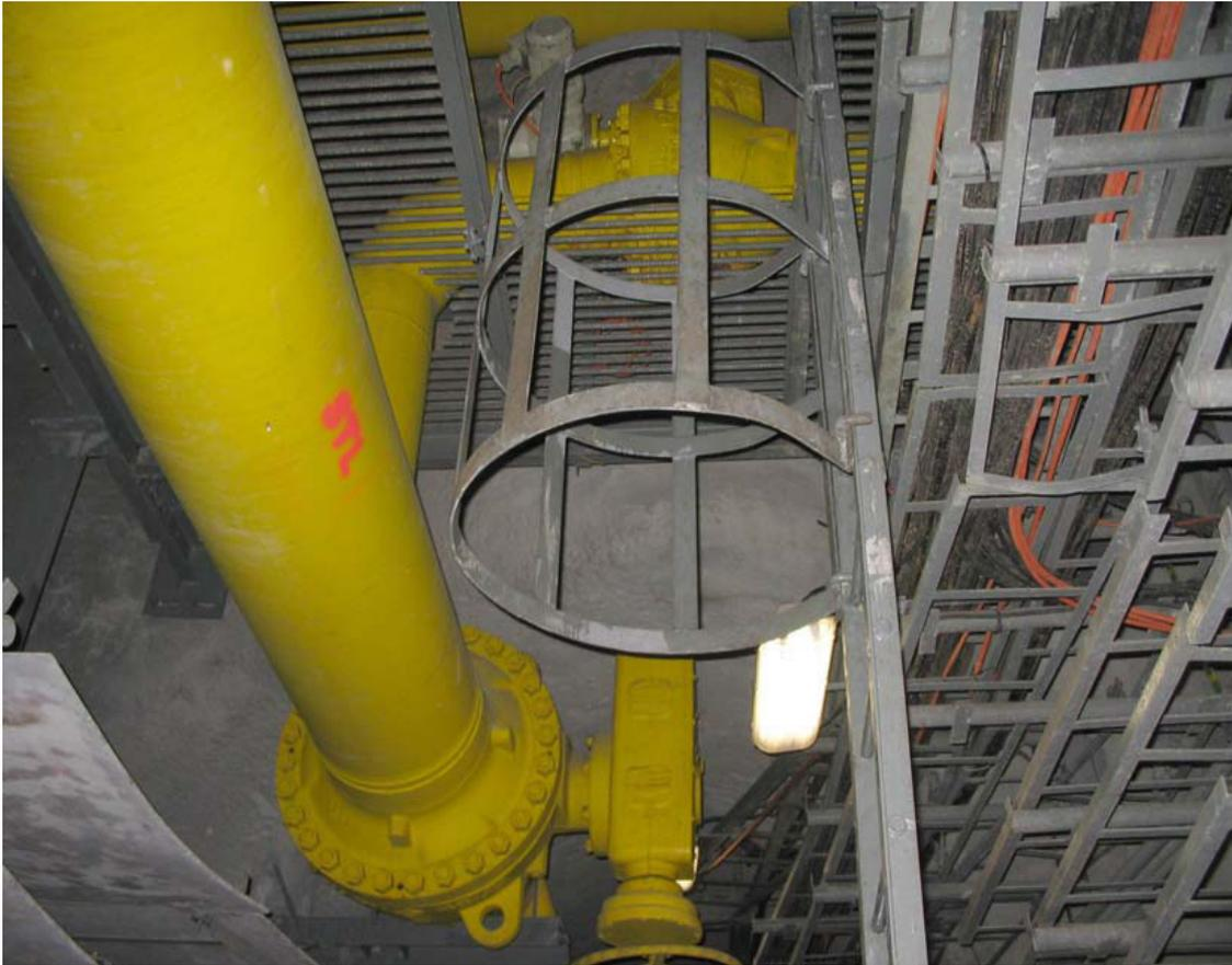
Photo 12 : Prague, vannes manuelle (en bas) et motorisée (en haut) des conduites de transport de gaz (jaune)
