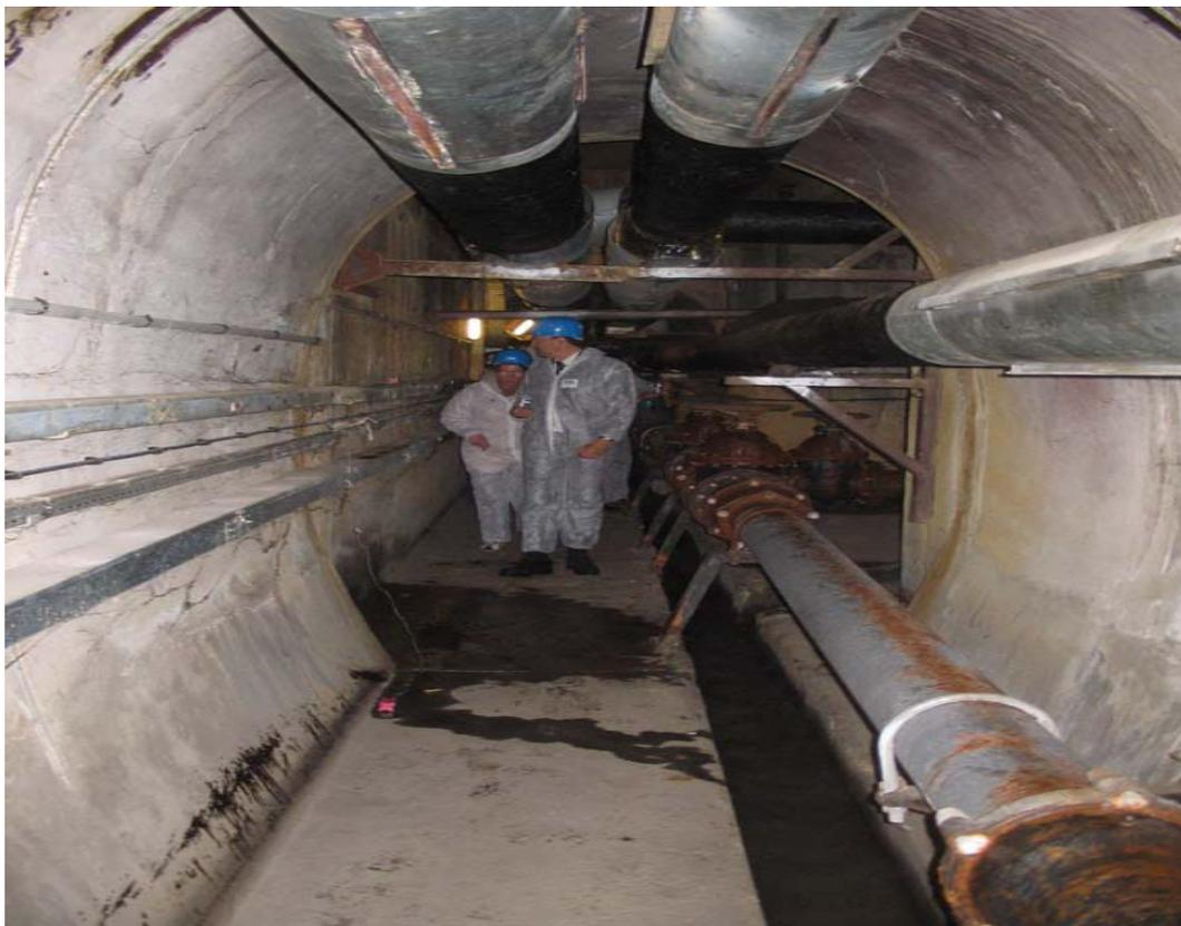
**Photo 4 : Besançon, la galerie avec, à partir du haut et en sens horaire : le chauffage urbain, l'eau, la cunette d'égout, les câbles BT, les câbles MT et les télécommunications.**
